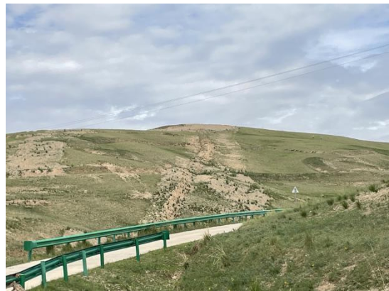
管线植被恢复状况
