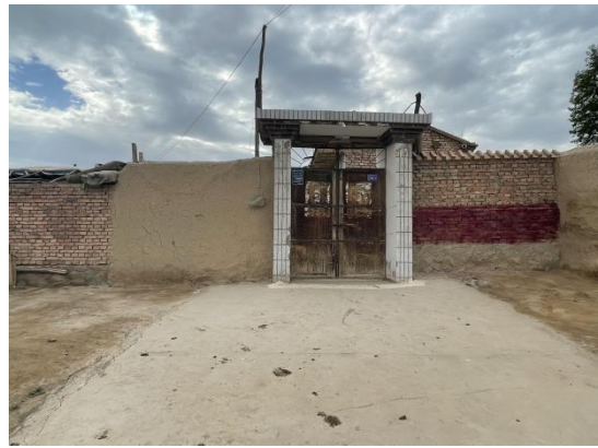
施工营地租用附近村庄房屋
